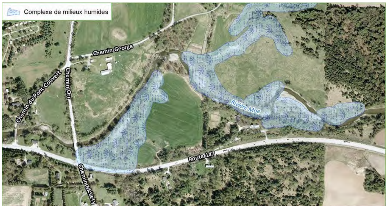
FIGURE 44 - EXEMPLE DE MILIEU HUMIDE DE TYPE MARÉCAGE EN BLEU ADJACENT À LA RIVIÈRE MOE JOUANT UN RÔLE TRÈS ÉLEVÉ POUR LA STABILISATION DES RIVES (WATERVILLE)
